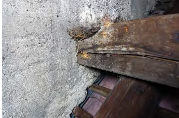
Abbildung 4-101: Mittelpfette Schaden am Auflager zur Giebelwand [105]
