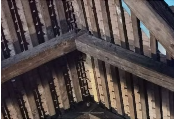
Abbildung 4-57: Beispiel des Scherzapfens im Dachwerk in der Humboldtstraße 10; links: Foto der Firstverbindung [103]; rechts: axonometrische Darstellung des „Scherzapfen“
