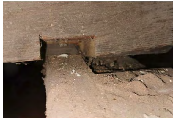
Abbildung 4-59: Foto der Verbindung des Kehl balkens mit dem Rähm [103]
