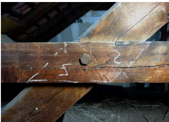
Abbildung 4-91: Beispiel eines schrägen Halbkamms bei dem Dachwerk in der Bergmannngasse 19; links: Foto der Verbindung [105]; rechts: axonometrische Darstellung der Verbindung
