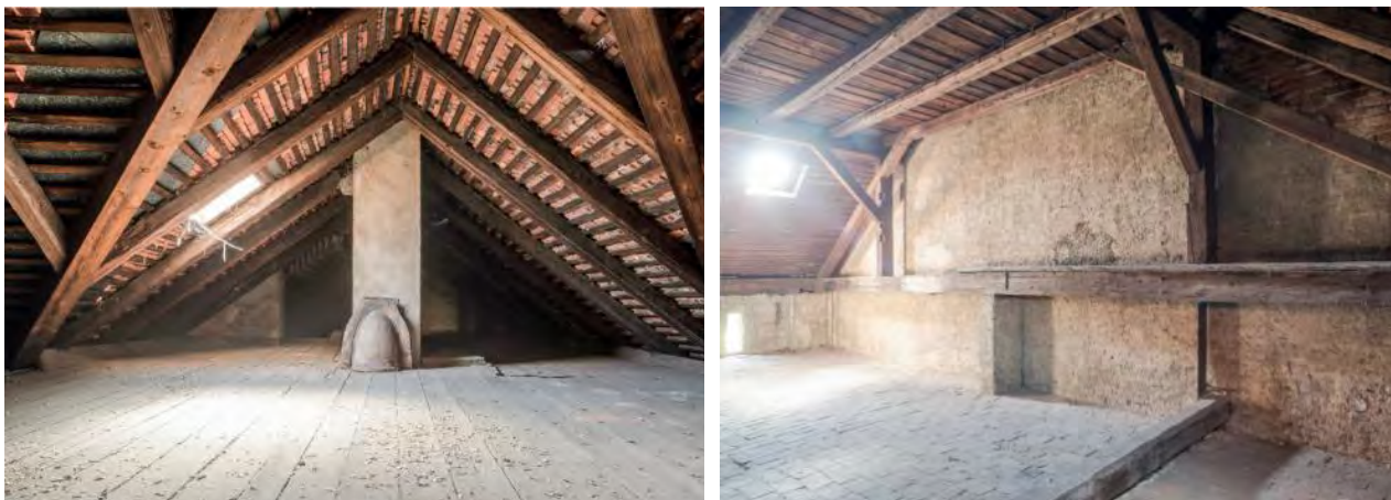
Abbildung 4-34: Innenansicht des Dachwerks in der Leonhardstraße 6 [101]
