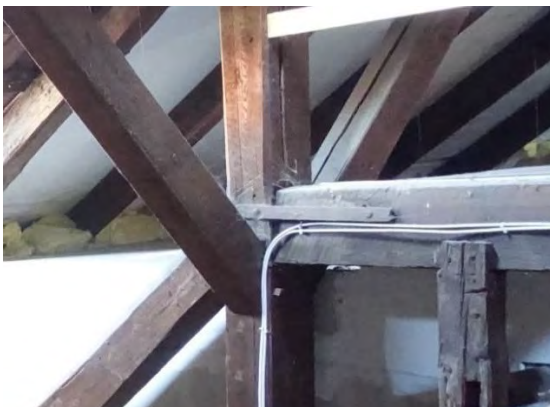
Abbildung 4-94: Beispiel des schrägen Zapfens bei dem Dachwerk in der Bergmannsgasse 19; links: Foto der Verbindung [105]; rechts: axonometrische Darstellung der Verbindung
