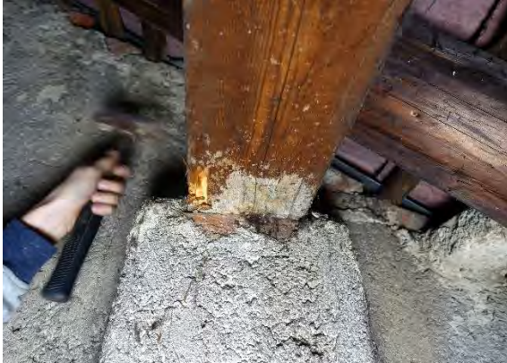
Abbildung 4-101: Mittelpfette Schaden am Auflager zur Giebelwand [105]
