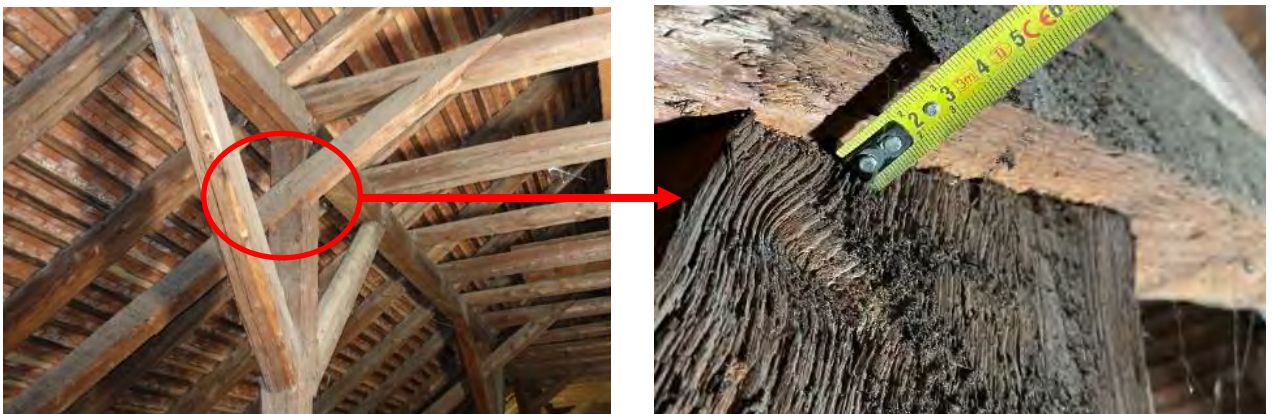
Abbildung 4-25: Überblattung der Stuhlsäule und Strebe, rechts: Ansicht der Klaffung ca. 3,0 cm
