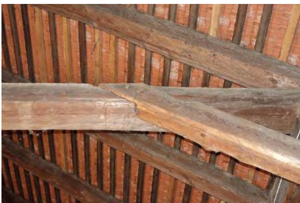
Abbildung 4-15: Beispiel einer Weißschwanzverbindung des Dachwerks in der Laimburggasse 19; links: Foto der Weißschwanzverbindung; rechts: axonometrische Darstellung der Weißschwanzverbindung
