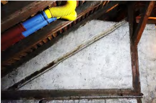
Abbildung 4-16: Einmauerung des Vollgespärres im Bereich des Stiegenhauses; rechts: Feuchtemessgerät
