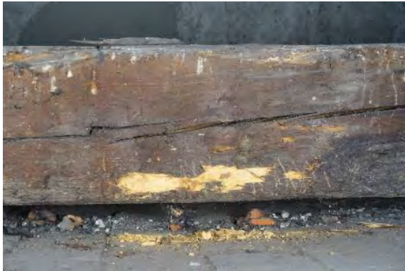
Abbildung 4-77: Fäulnisschäden bei dem Bundtram
