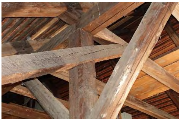
Abbildung 4-14: Beispiel einer Überblattung des Dachwerks in der Laimburggasse 19; links: Foto der Überblattung; rechts: axonometrische Darstellung der Überblattung
