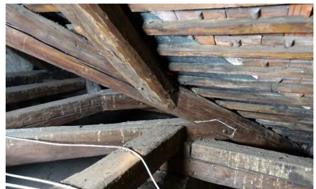
Abbildung 3-79: Knoten des Dachwerks eines Gründerzeitgebäudes in Graz
