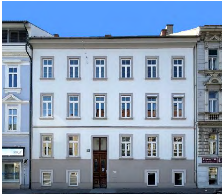
Abbildung 4-63: Ansicht des Objekts in der Conrad-von-Hötzendorf-Straße 56
