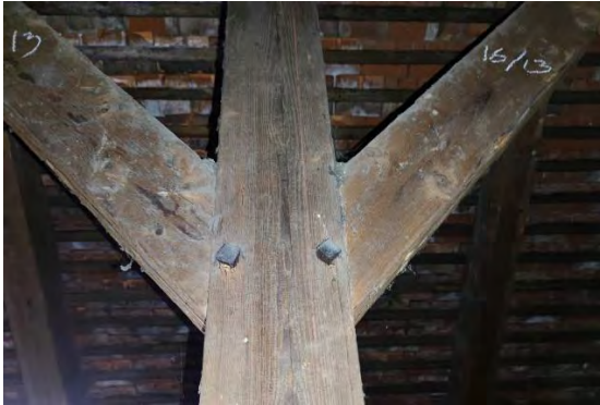
Abbildung 4-40: Beispiel des schrägen Zapfens am Kopfband des Dachwerks in der Leonhardstraße 6; links: Foto der Verbindung [102]; rechts: axonometrische Darstellung der Verbindung
