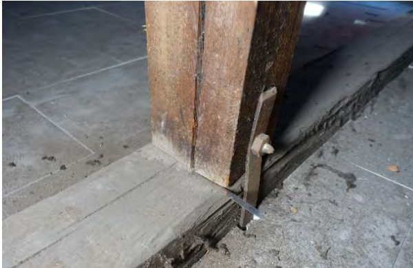
Abbildung 4-92: Beispiel des einfachen Zapfens mit Eisenverhängung bei dem Dachwerk in der Bergmannsgasse 19; links: Foto der Verbindung [105]; rechts: axonometrische Darstellung
