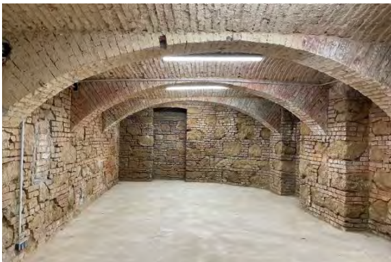
Abbildung 3-19: links: Kappengewölbe [53]; rechts: Preußische Kappe [54]
