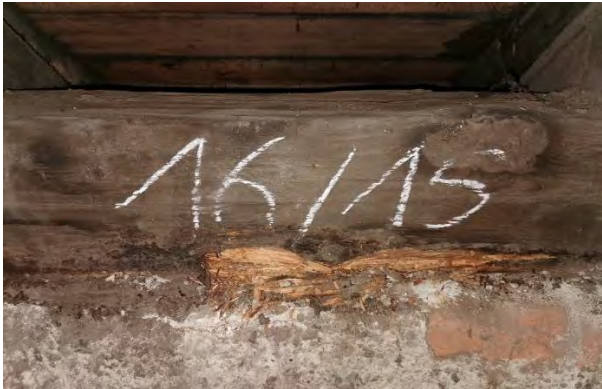
Abbildung 4-60: Fäulnisschaden der Mauerbank [103]
