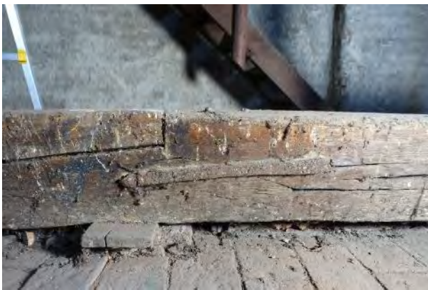
Abbildung 4-72: Beispiel des „schrägen Blattes“; links: Foto der Verbindung; rechts: axonometrische Darstellung der Verbindung
