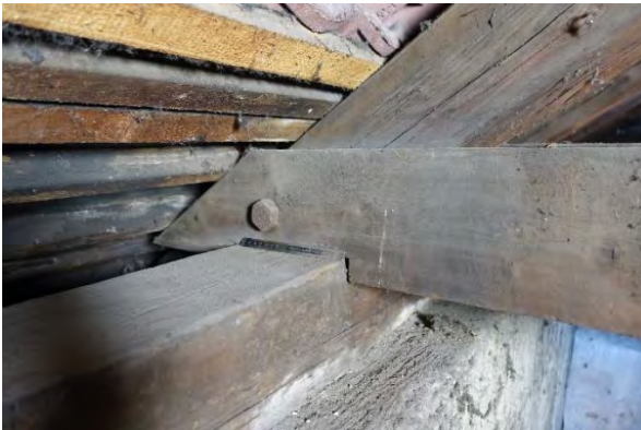
Abbildung 4-90: Beispiel einer Vollkammverbindung bei dem Dachwerk in der Bergmannngasse 19; links: Foto der Verbindung [105]; rechts: axonometrische Darstellung der Verbindung
