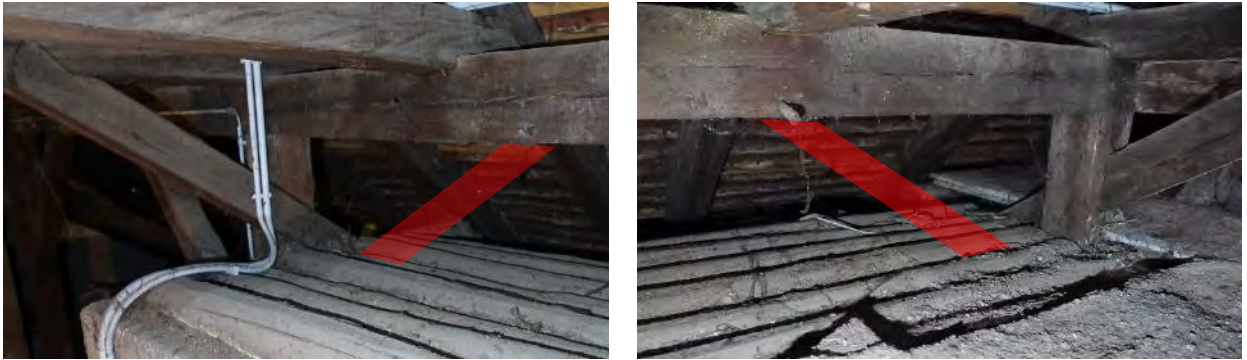
Abbildung 4-24: entfernte Kopfbänder, links Achse 5-5, rechts Achse 4-4
