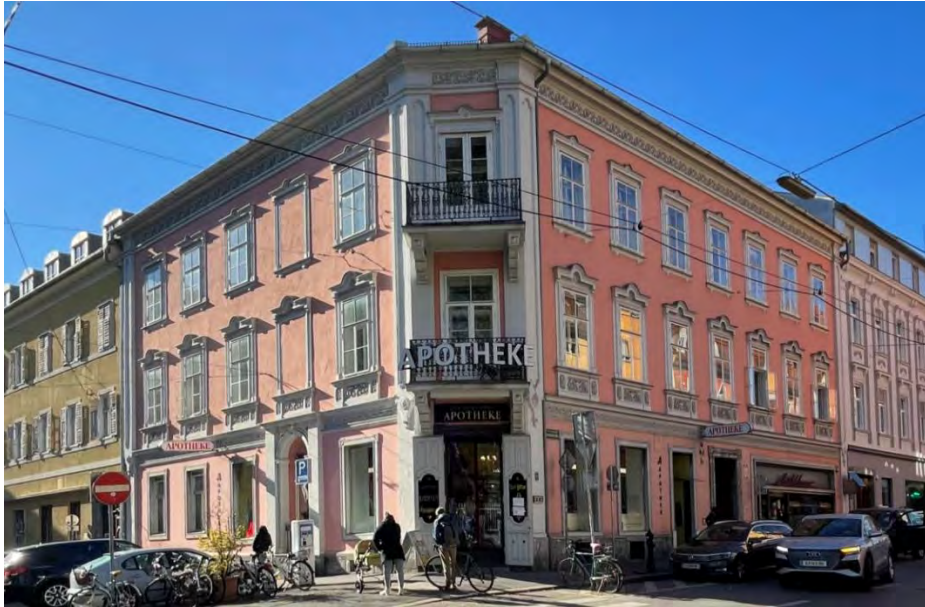
Abbildung 4-30: Ansicht des Objektes „Leonhardstraße 6“
