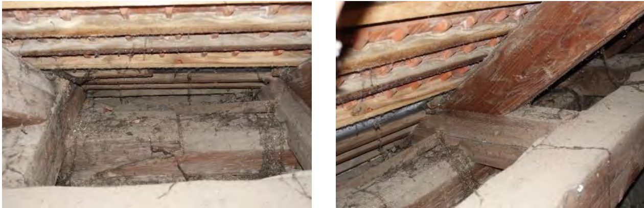
Abbildung 4-27: Verschmutzung der Bauteile
