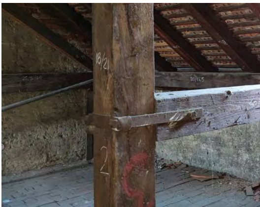
Abbildung 4-39: Beispiel des einfachen Zapfens bei der Verbindung der Stuhlsäule mit dem Mauerbankriegel des Dachwerks in der Leonhardstraße 6; links: Foto der Verbindung [102]; rechts: axonometrische Darstellung der Verbindung
