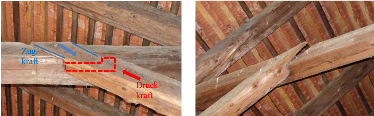
Abbildung 4-21: Weißschwanzverbindung; links: Prinzip der Kraftübertragung; rechts: klaffende Verbindung
