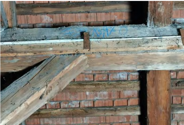
Abbildung 4-58: Beispiel des schrägen Zapfens im Dachwerk in der Humboldtstraße 10; links: Foto der Verbindung [103]; rechts: axonometrische Darstellung des schrägen Zapfens
