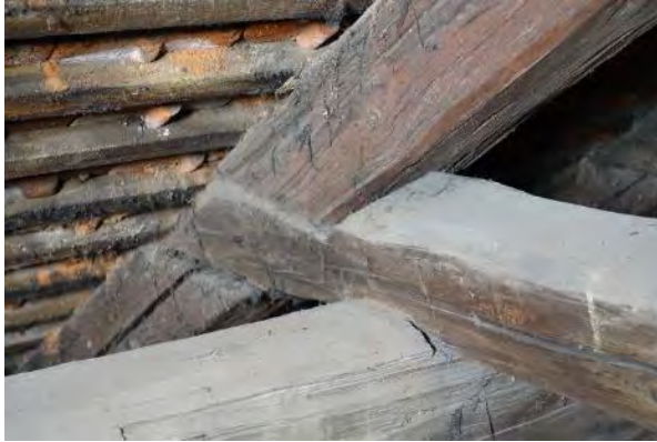
Abbildung 4-74: Beispiel einer Weißschwanz- und Vollkamm-Verbindung; links: Foto der Verbindung; rechts: axonometrische Darstellung der Verbindung
