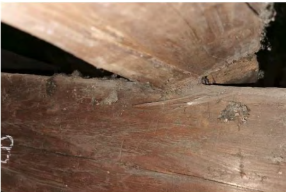
Abbildung 4-59: Foto der Verbindung des Kehl balkens mit dem Rähm [103]
