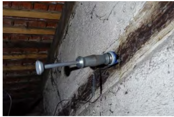
Abbildung 4-16: Einmauerung des Vollgespärres im Bereich des Stiegenhauses; rechts: Feuchtemessgerät
