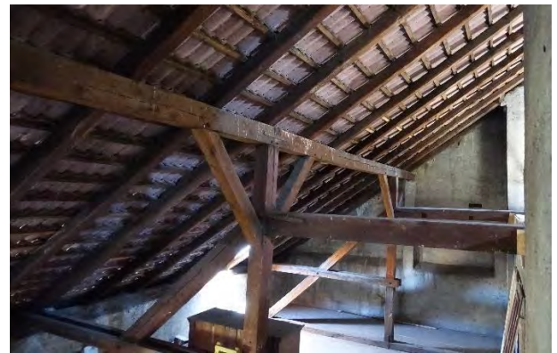
Abbildung 4-86: Innenansicht des Dachwerkes in der Bergmannngasse 19 [105]
