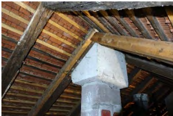
Abbildung 4-19: Innenansicht Sparrenverstärkung
