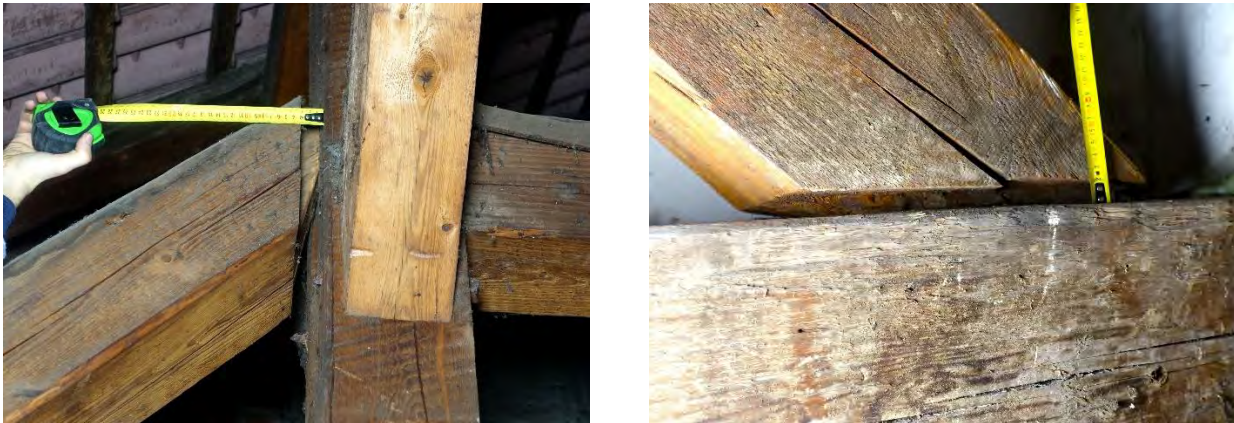
Abbildung 4-95: Lageverschobene Strebe; links: Achse 1-1; rechts: Achse 3-3 [105]
