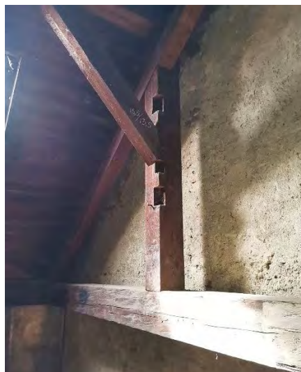
Abbildung 4-44: Querschnittreduzierung der Stuhlsäule; links: Foto der Stuhlsäule [102]; rechts: Abmessungen der Ausschnitte
