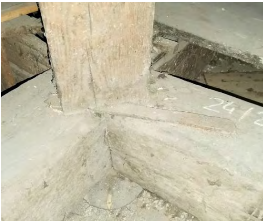
Abbildung 4-41: Beispiel des einfachen Zapfens bei der Eckverbindung der Bundtrame des Dachwerks in der Leonhardstraße 6; links: Foto der Verbindung [102]; rechts: axonometrische Darstellung der Verbindung
