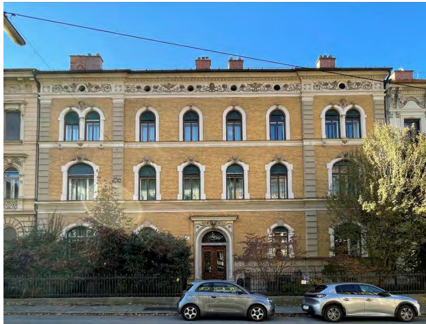
Abbildung 4-82: Ansicht auf das Gebäude „Bergmannngasse 19“
