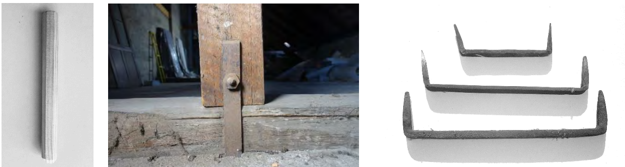
Abbildung 3-88: links: Holznagel [93]; mitte: Eisenklammer [96]; rechts: schmiedeeiserner Band, mit Bolzen gesichert
