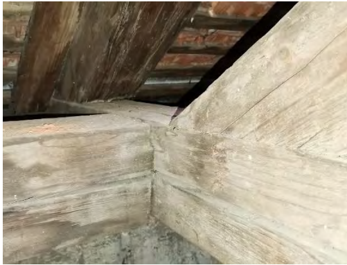
Abbildung 4-38: Beispiel des einfachen Zapfens bei der Verbindung des Mauerbankriegels mit dem Wechselbalken des Dachwerks in der Leonhardstraße 6; links: Foto der Verbindung [102]; rechts: axonometrische Darstellung der Verbindung
