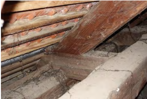
Abbildung 4-13: Beispiel des schrägen Zapfens im Dachwerk in der Laimburggasse 19; links: Foto der Verbindung; rechts: axonometrische Darstellung der Zapfenverbindung
