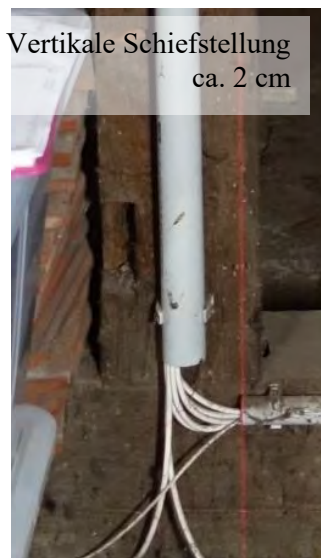
Abbildung 4-23: geringfügige Schiefstellung der Stuhlsäulen; links: Richtung Innenhof; rechts: straßenseitig
