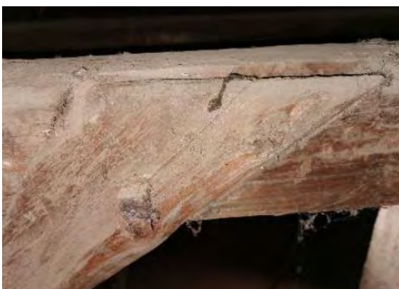
Abbildung 4-62: Klaffende Weißschwanzverbindung [103]
