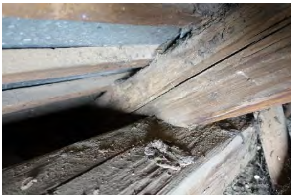
Abbildung 4-73: Beispiel einer Aufklauung; links: Foto der Verbindung; rechts: axonometrische Darstellung der Verbindung
