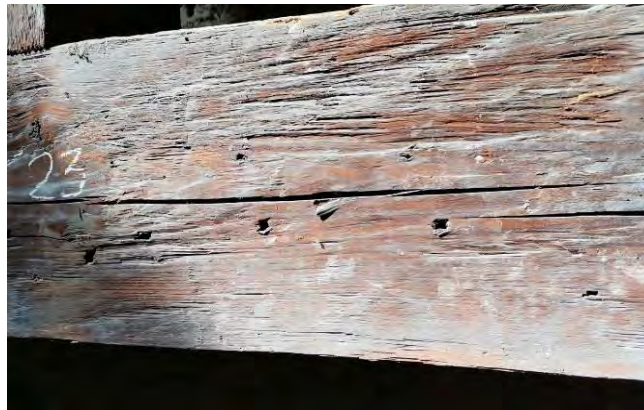
Abbildung 4-42 Insektenbefall bei dem Mauerbankriegel [102]
