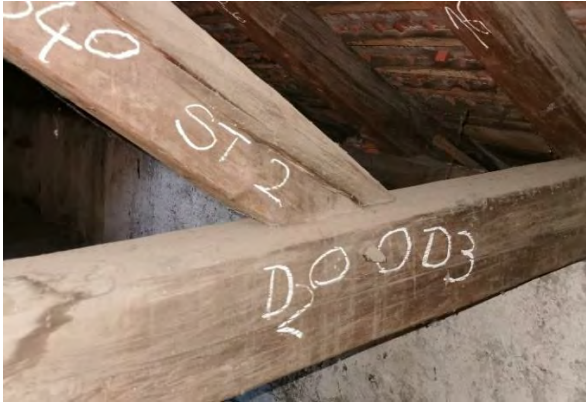
Abbildung 4-55: Beispiel des schrägen Zapfens mit Holznagel im Dachwerk in der Humboldtstraße 10; links: Foto der Verbindung [103]; rechts: axonometrische Darstellung des schrägen Zapfens
