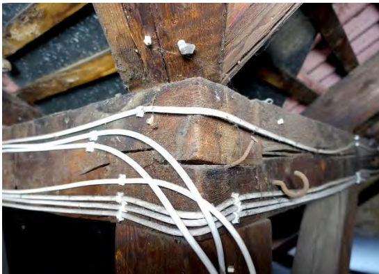
Abbildung 4-93: Beispiel eines hakenförmigen Eckblattes bei dem Dachwerk in der Bergmannsgasse 19; links: Foto der Verbindung [105]; rechts: axonometrische Darstellung der Verbindung
