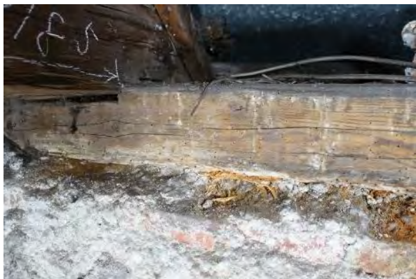
Abbildung 4-75: Insektenbefall und Fäulnisschäden bei der Mauerbank
