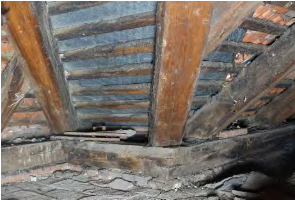
Abbildung 4-80: Verschmutzung der Fußpunkte des Dachwerks
