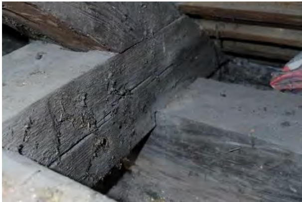
Abbildung 4-12: Beispiel der Halbkamm-Verbindung des Dachwerks in der Laimburggasse 19; links: Foto der Halbkamm-Verbindung; rechts: axonometrische Darstellung der Halbkamm-Verbindung
