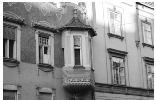
Abbildung 3-12: Erker des Gebäudes in Elisabethstraße 35, Graz
