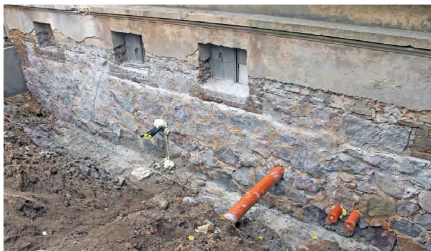
Abbildung 3-17: freigelegtes Fundament und Sanierungsmaßnahme eines Gründerzeithauses [44]
