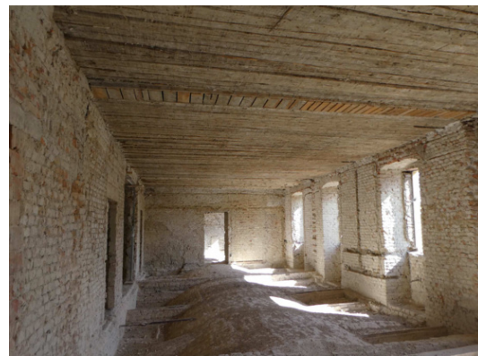
Abbildung 4-13: Wände in einem Gründerzeithaus (links: Ziegelmauerwerk mit Dippelbaumdecke n.u.; rechts: Ziegelmauerwerk mit Tonnengewölbe n.u.) [32]
