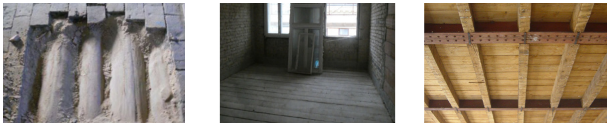
Abbildung 4-39: Holzdeckenarten (links: Dippelbaumdecke; mittig: Tramdecke; rechts: Tramtraversdecke) [37]
