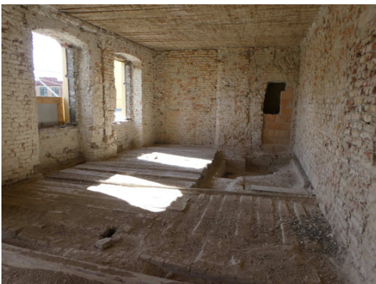
Abbildung 4-13: Wände in einem Gründerzeithaus (links: Ziegelmauerwerk mit Dippelbaumdecke n.u.; rechts: Ziegelmauerwerk mit Tonnengewölbe n.u.) [32]
