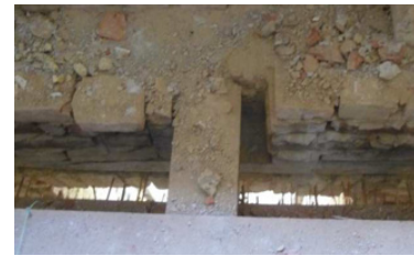
Abbildung 4-14: links: Klammerschließe [30]; Verbindung mit der Decke (mittig: Schließenverbindung AW mit Dippelbaumdecke; rechts: Schließenverbindung AW Holztram) [32]
