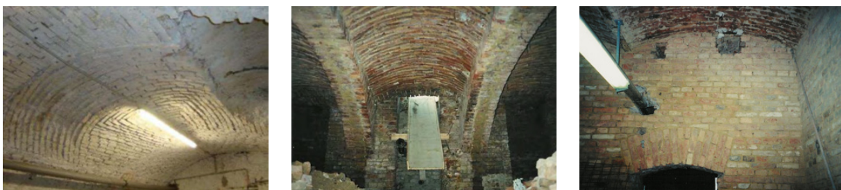
Abbildung 4-51: Gewölbearten (links: Tonnengewölbe; mittig: Kappengewölbe; rechts: Preußische Kappe) [36]
