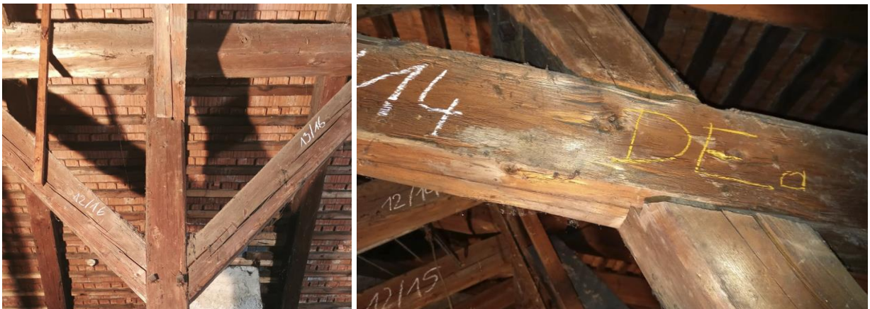
Abbildung 4-46: DEa Vollkammverbindung Sparren-Stuhlsäule
