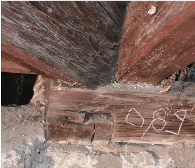
Abbildung 4-51: West-Süd Mauerbank-Verbindung
