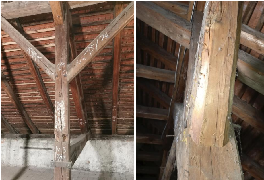
Abbildung 4-31: DCb Bestandsaufnahme (links: Ansicht Stuhlwand; rechts: Anschluss Kopfbänder an Stuhlsäule)
