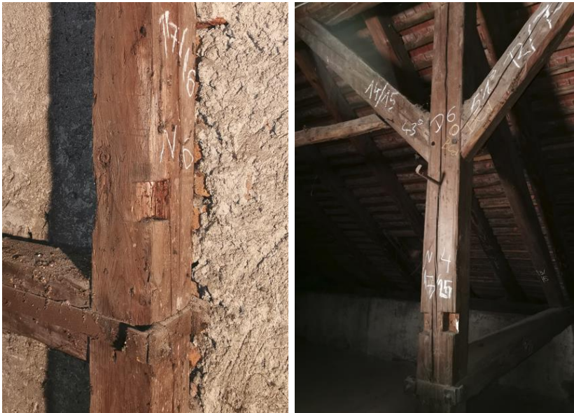
Abbildung 4-49: Querschnittsschwächungen
