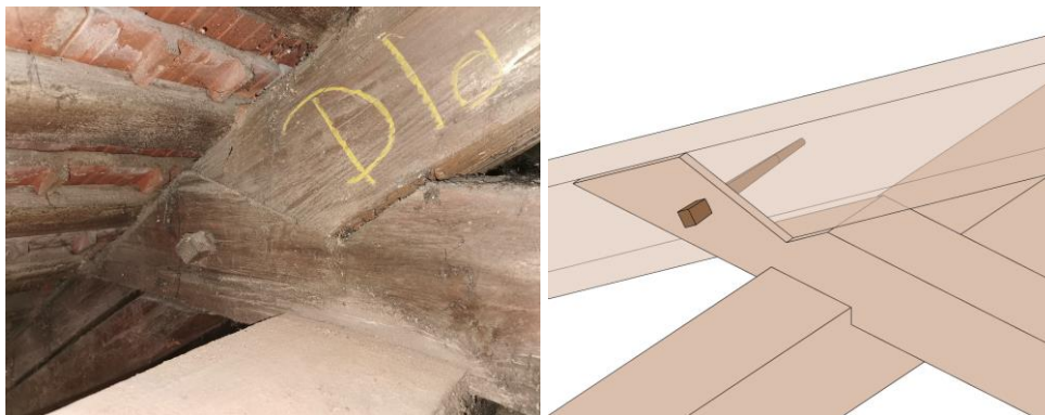
Abbildung 4-43: Verbindung von Kehlbalken mit Sparren mittels „Weißschwanz“
