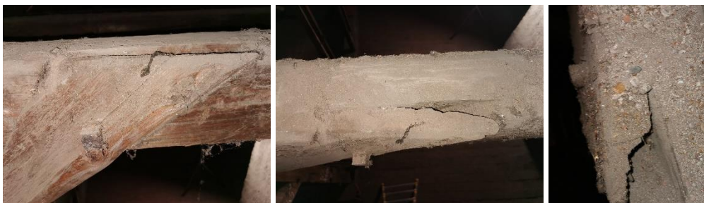
Abbildung 4-53: Verbindung Rähm und Kopfband
