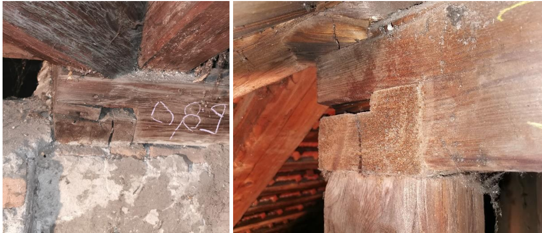
Abbildung 4-45: Schwalbenschwanz Eckblatt (links: Mauerbank-Mauerbank; rechts: Rähm-Rähm)
