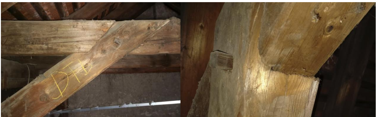
Abbildung 4-41: Verbindung von einer Strebe mit Kehlbalken mittels „Weißschwanz“
