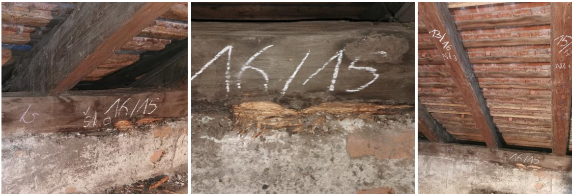
Abbildung 4-55: Feuchtigkeitsschaden
