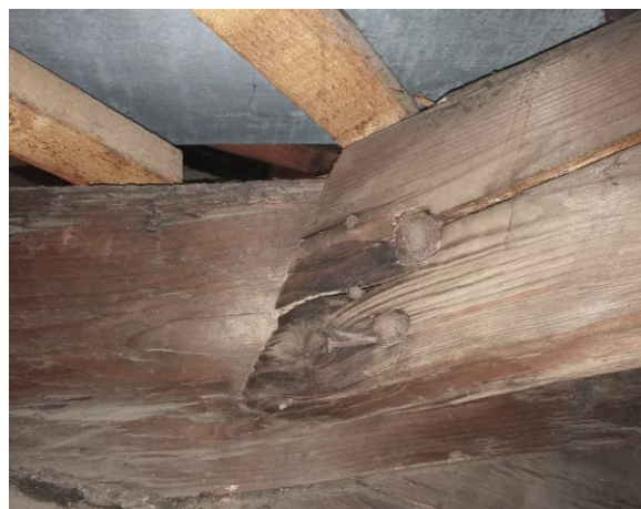
Abbildung 4-39: Absicherung Sparren an der Ichse
