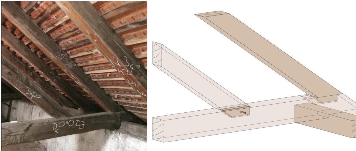
Abbildung 4-33: Verbindung Mauerbankriegel mit einer Strebe und eines Sparrens
