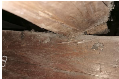
Abbildung 5-7: Kehlbalken Verdrehung in Achsen 3.3 und 3.5
