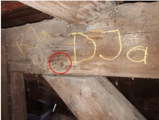
Abbildung 4-54: Fehlender Holznagel
