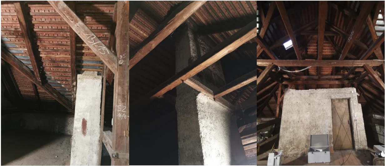
Abbildung 4-11: Dachstuhl in der Humboldtstraße 10 (links: Kamin im Übergang; mitte: Kamin im Hauptdach; rechts: Zugang zum Treppenhaus)
