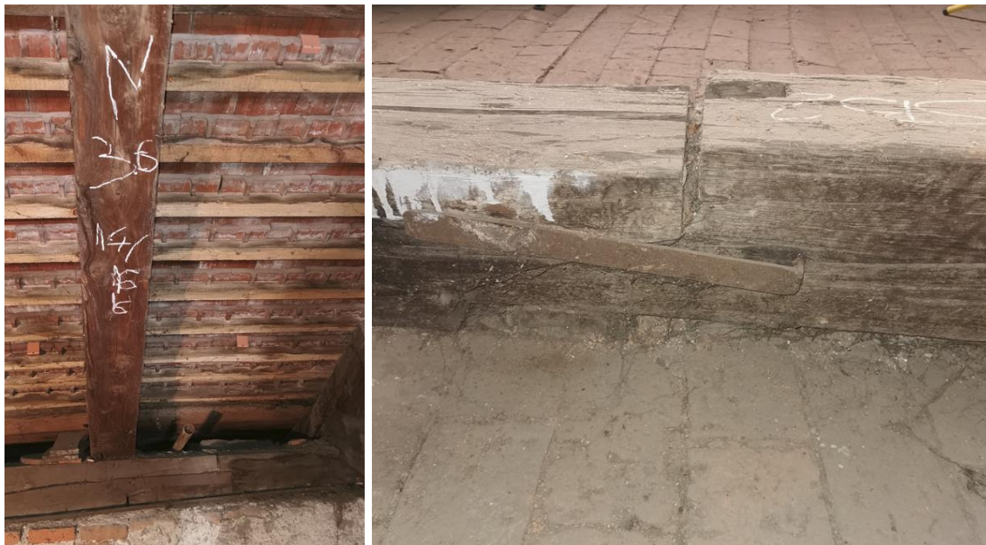
Abbildung 4-48: Blattverbindung (links: Mauerbank; rechts: Schwelle)
