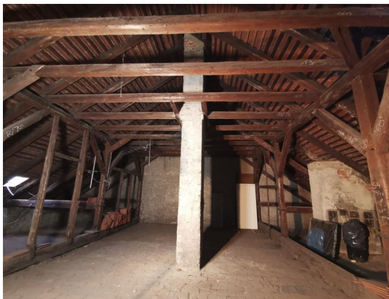
Abbildung 4-7: Innenansicht des Dachraums Humboldtstraße 10 (Blickrichtung nach Osten)
