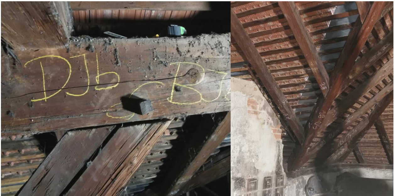
Abbildung 4-37: Schräge Zapfen-Verbindung (links: Kopfband-Rähm; rechts Sparren-Ichse)
